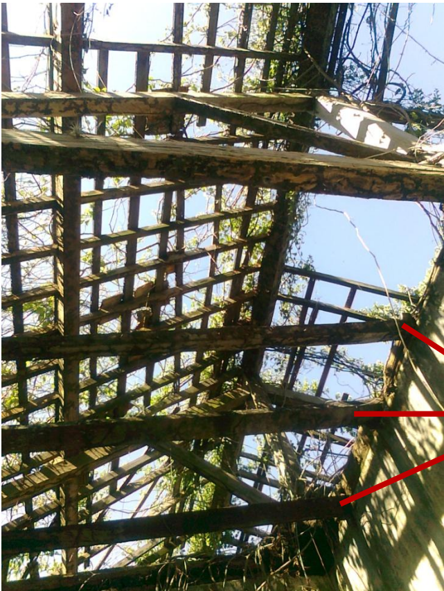
Foto 12 – Cômodo à esquerda da porta principal. Visíveis três das peças onde eram pregadas as tábuas do forro
