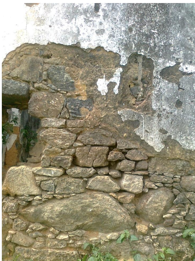
Foto 3 – Pedra marroada. Parede externa dos fundos da casa onde provavelmente seria a cozinha.
