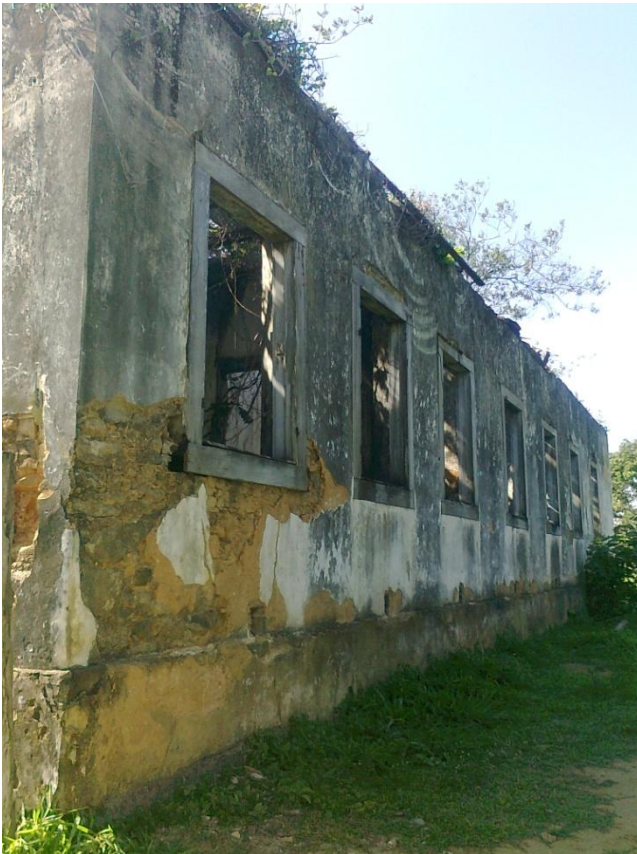
Foto 2 – Fachada traseira do Casarão com 6 aberturas de janelas e uma porta.
