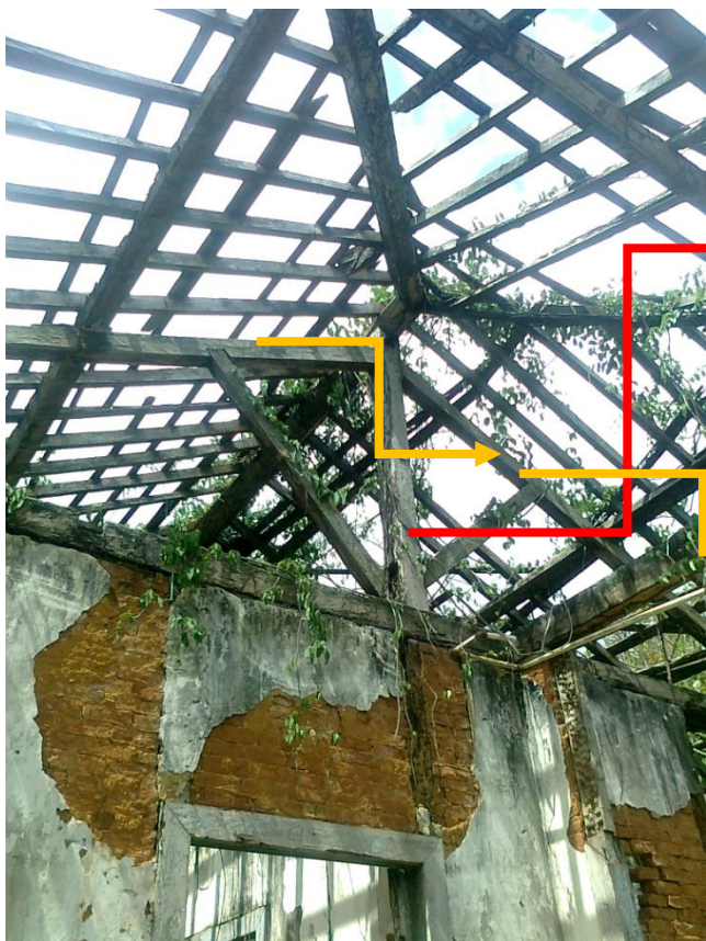
Foto 9 – Estrutura do telhado colonial de 4 águas.
