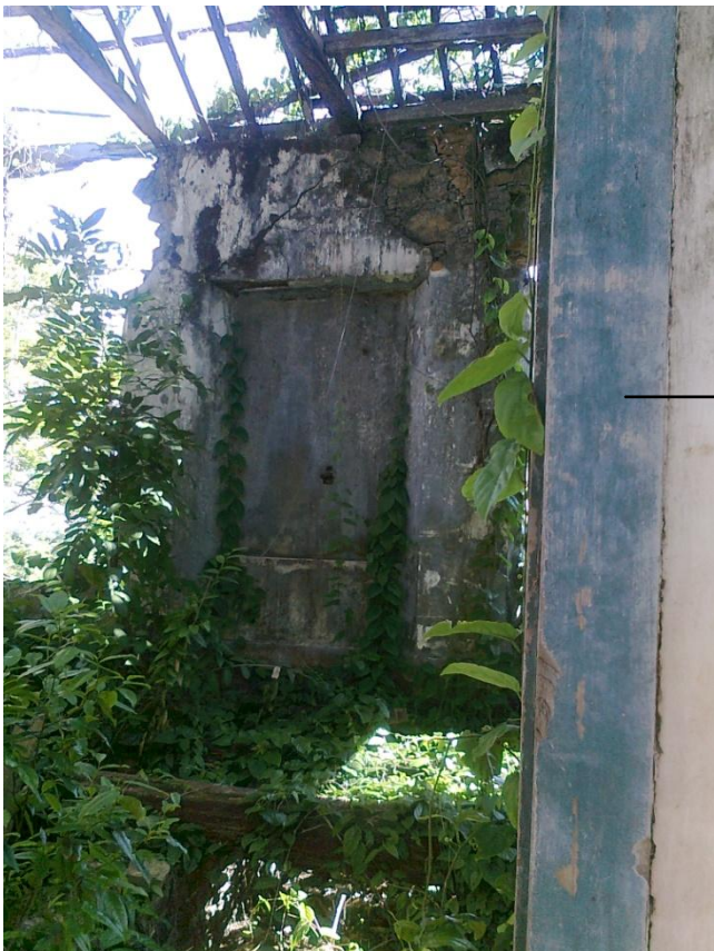
Foto 8 – Na parede, inicialmente com 4 janelas, é bem visível o fechamento posterior.
